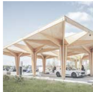
LADESTATION, SOM MODULÆRT BYGGERI I TRÆ, COBE ARKITEKTER
