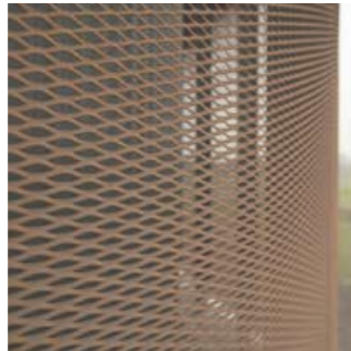
INDDÆKNING AF VENTILATIONSANLÆG
