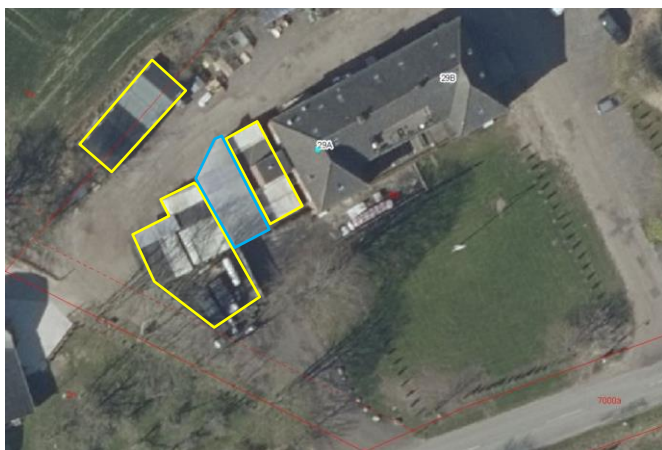
Illustration af containere (gul markering) der oplagres samt overdækningen (blå markering), der er opført uden forudgående landzonetilladelse
