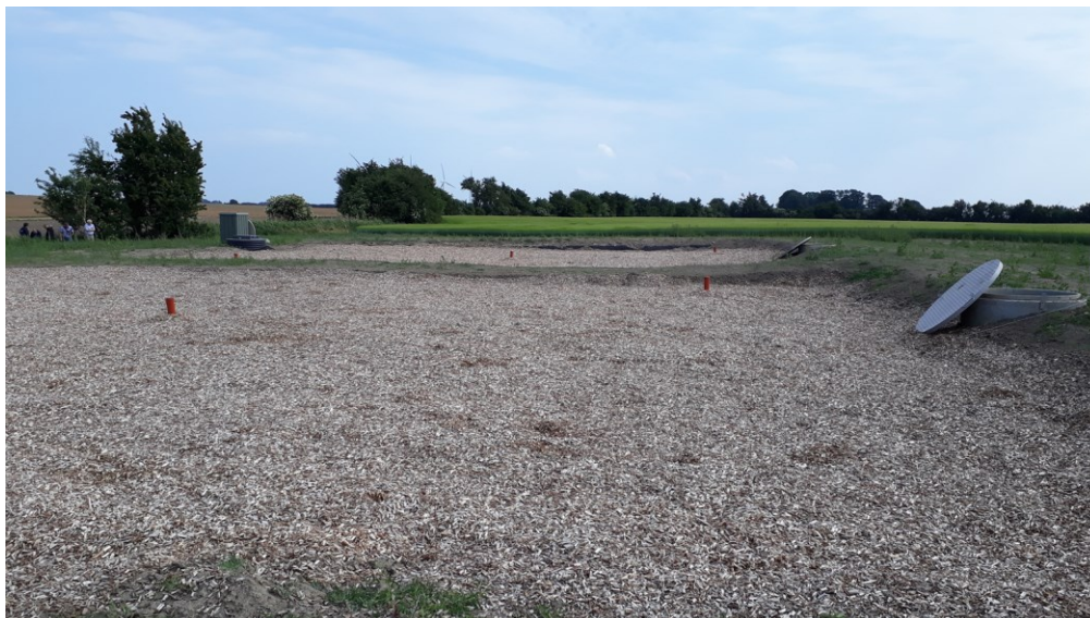
Minivådområde med filtermatrice ved Gyldenholm Gods, Slagelse. Forskningsanlæg med tre bassiner med henblik på test. Foto: Susanne Brusvang Hjuler.
