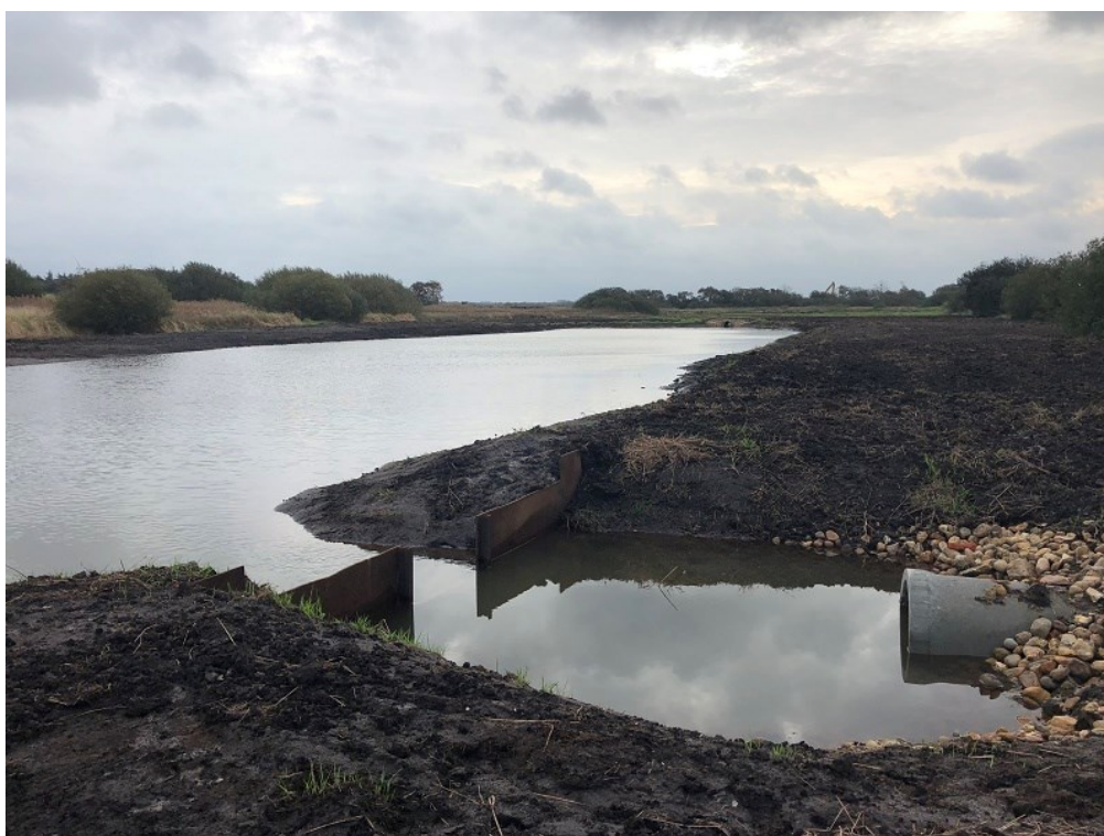
Nyetableret okkerrensingsanlæg ved Lykkegrøften, der er et okkerbelastet tilløb til kommunevandløbet Hemmet Bæk, i Ringkøbing-Skjern Kommune. Det nye okker-rensningsanlæg er gennemført i efteråret 2018 og fotoet viser det nye afløb fra anlægget. Foto: Per Søby Jensen.
