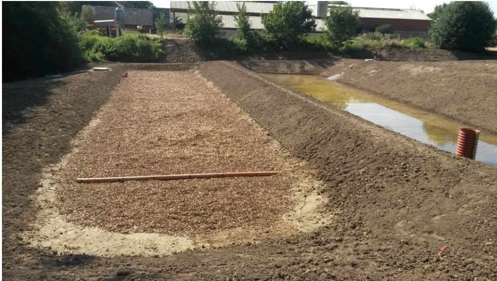
Nyanlagt minivådområde med matrice ved Fensholt, Odder. Anlægget har stuvningsbassin (til højre) og matricebassin. Foto: Susanne Brusvang Hjuler.
