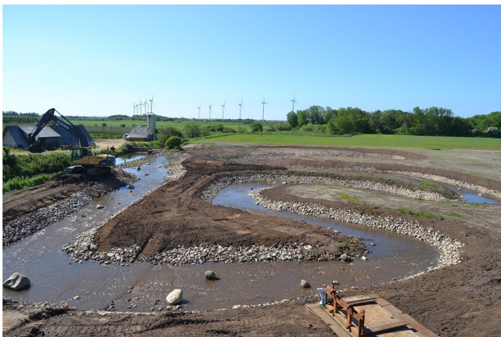
Etablering af nyt omløbsstryk ved opstemningen for Klaptoft Dambrug, kommunevandløbet Venner Å i Ringøbing-Skjern Kommune. Projektet er udført i 2015. Her er dambrugsproduktionen bevaret, og der er etableret en ny ca. 400 m naturlig faunapassage uden om det eksisterende opstemningsanlæg. Foto: Per Søby Jensen.
