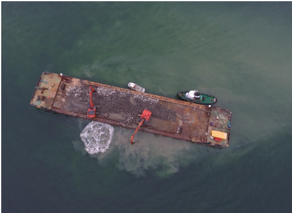
Etablering af stenrev ved Livø. Foto: Limfjordsrådet.
