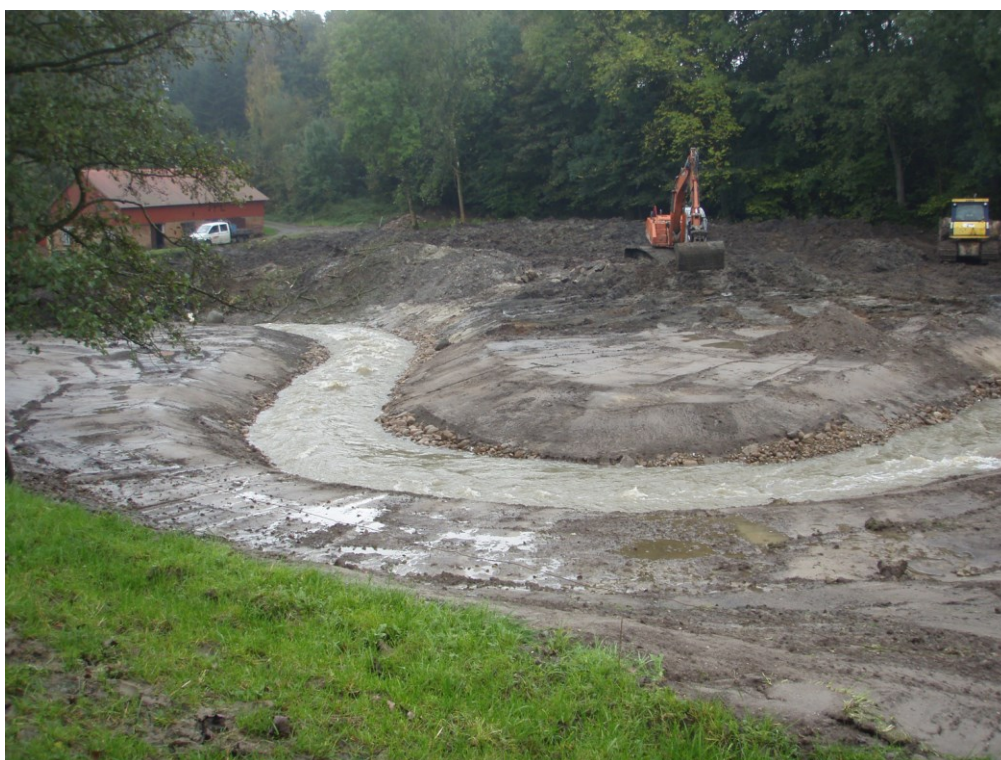
Etablering af faunapassage ved Bovballe Mølle, Vejle Kommune. 15. oktober 2014. Foto: Annette Bonde.
