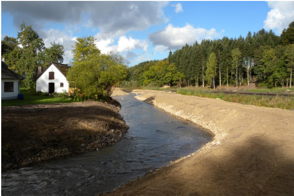
Matstrup Å, Horsens Kommune. Mølleopstemning er fjernet ved at udligne faldet for opstemningen. Foto: Tony Bygballer.
