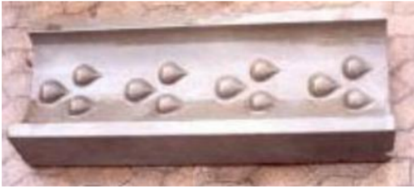
Princip over strukturer i bunden af i rør, som vil skabe varierede strømforhold gennem røret og forbedre passagemulighederne.
