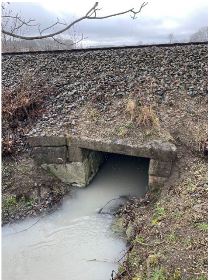
Figur 1: Udløb stenkiste er en firkantet konstruktion i granit. Indløb i stenkiste er en rund konstruktion i beton
