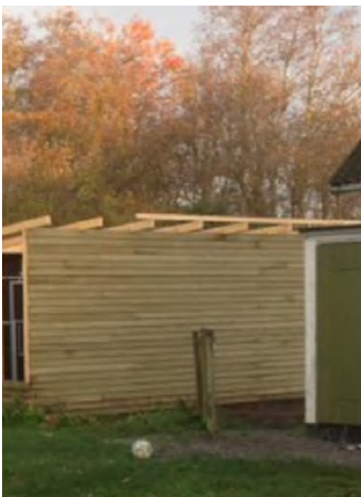
Foto 1: Facadebeklædning på bygning 3. Beklædningen på ansøgte tilbygning vil være tilsvarende.
