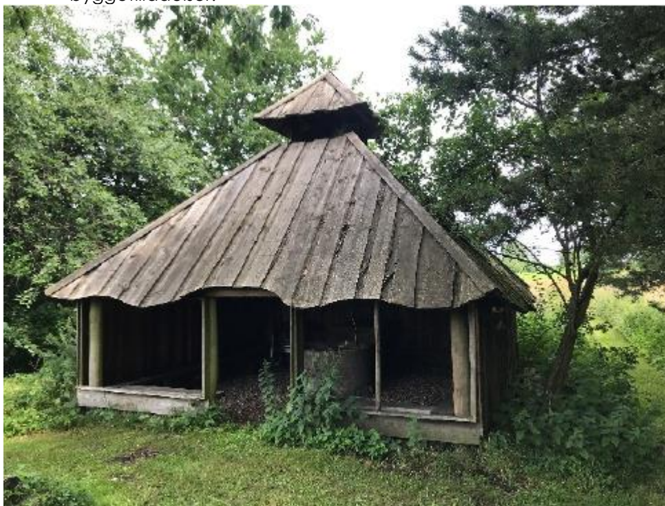
Figur 1 – Billede af bålhytten (bygning 13).
