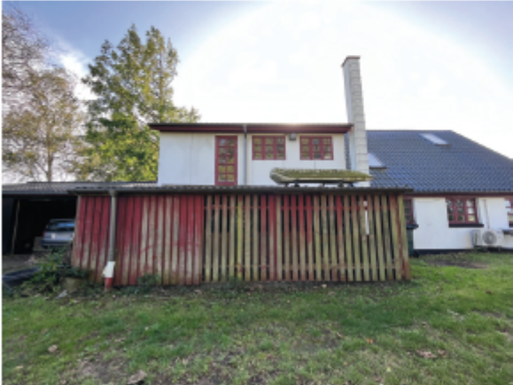
Figur 2: B1 og B2, samt vindfang, og skur på 23 m 2
