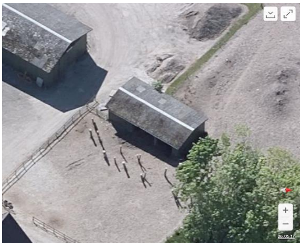
Foto 2: Skråfoto af hesteoverdækning set fra øst.
