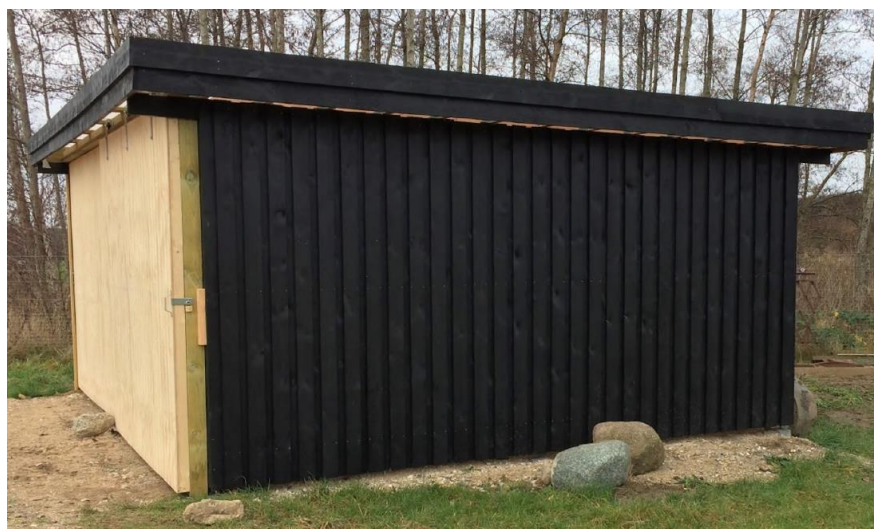
Billede 1: Ulovligt opført opbevaringsskur (fra øst)
