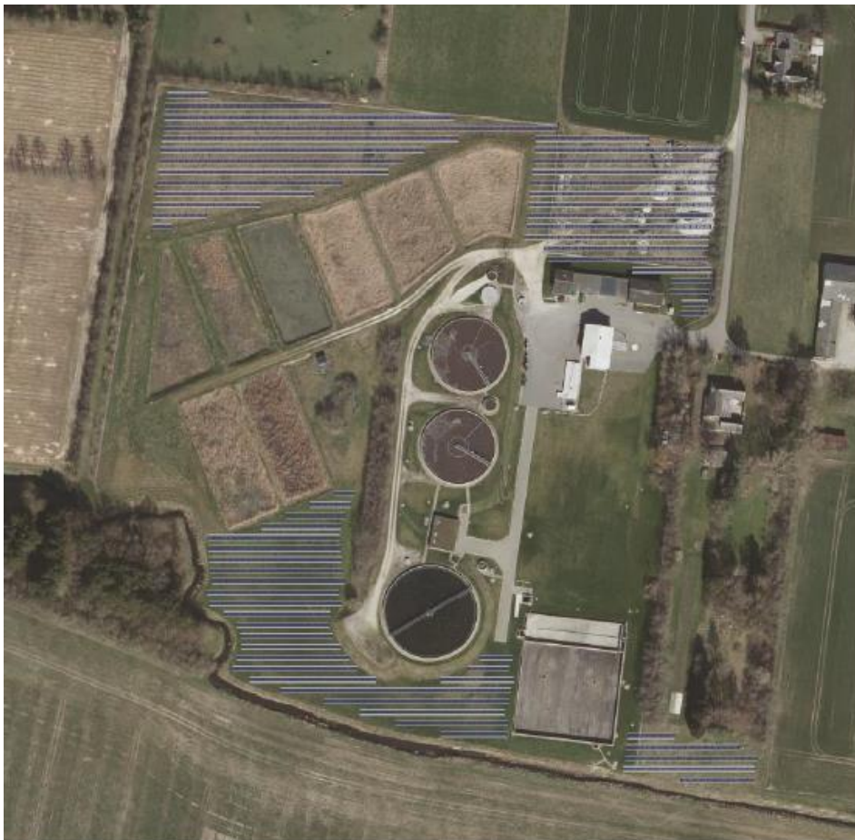
Figur 1 - Omtrentlig placering af solcellerne (i sydøstligt hjørne etableres IKKE solceller, trods illustration)
