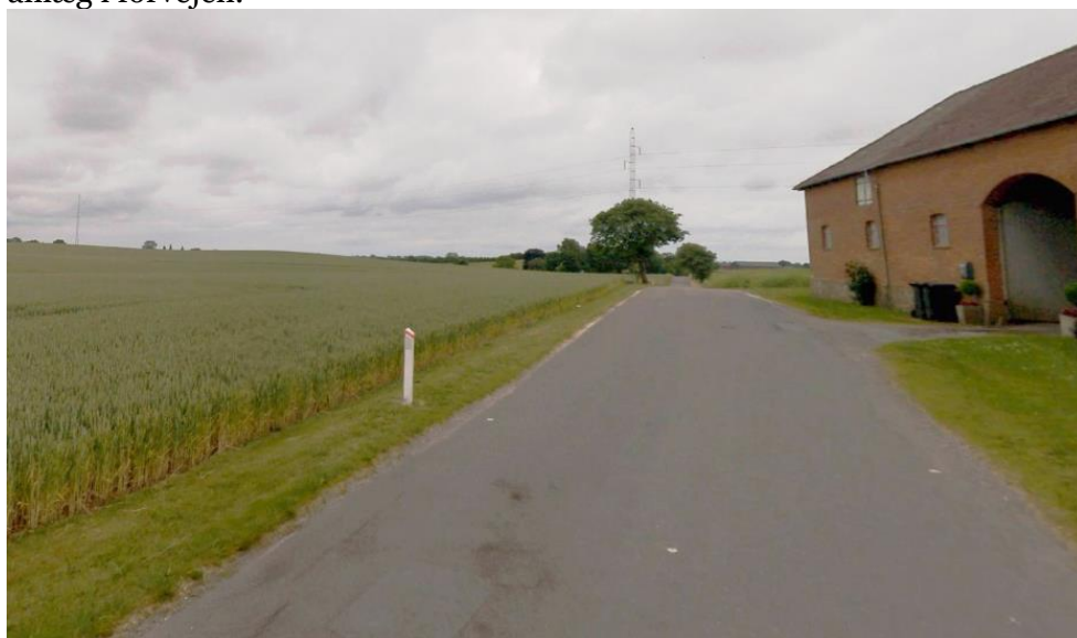
Figur 10 - Elmast mellem Hyllede og Orup – Her ses de i retning fra Hyllede mod Orup, ud for Hylledevej 17, som ses til højre i billedet.
