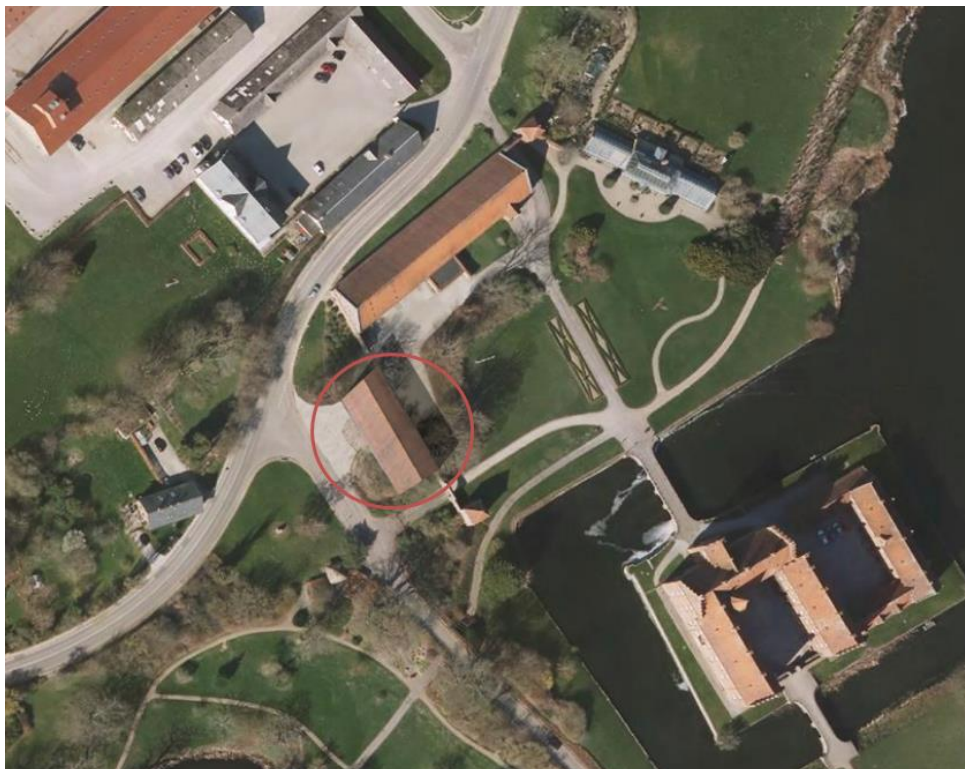
Figur 2 – Figuren viser Gisselfelds nuværende bygninger samt en visualisering af den nye udstillingsbygning (markeret med en rød cirkel).
