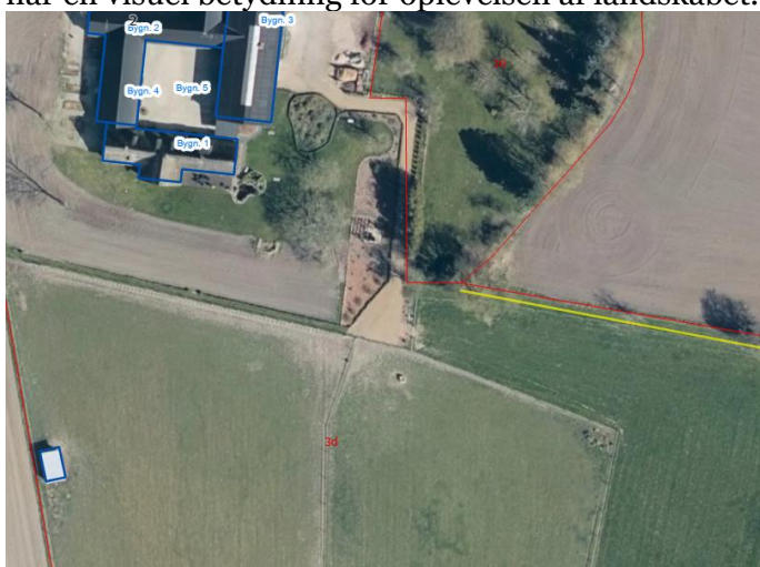
Figur 3 - Beskyttet sten- og jorddige markeret med gul
