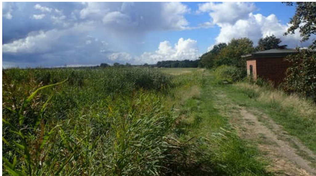
Figur 9-4 Pumpestation set fra vestsiden af diget.
