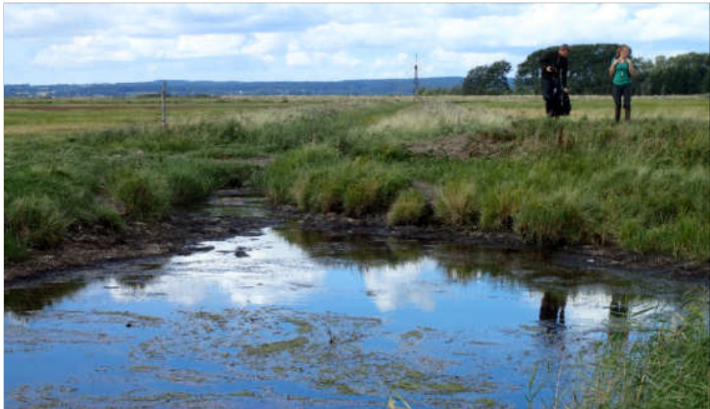
Figur 7-12 Dige set fra syd. På billedet tv for grøften er diget ikke højere end kote 0,6 og havvand kan således strømme ind på de bagvedliggende enge ved højvande.
