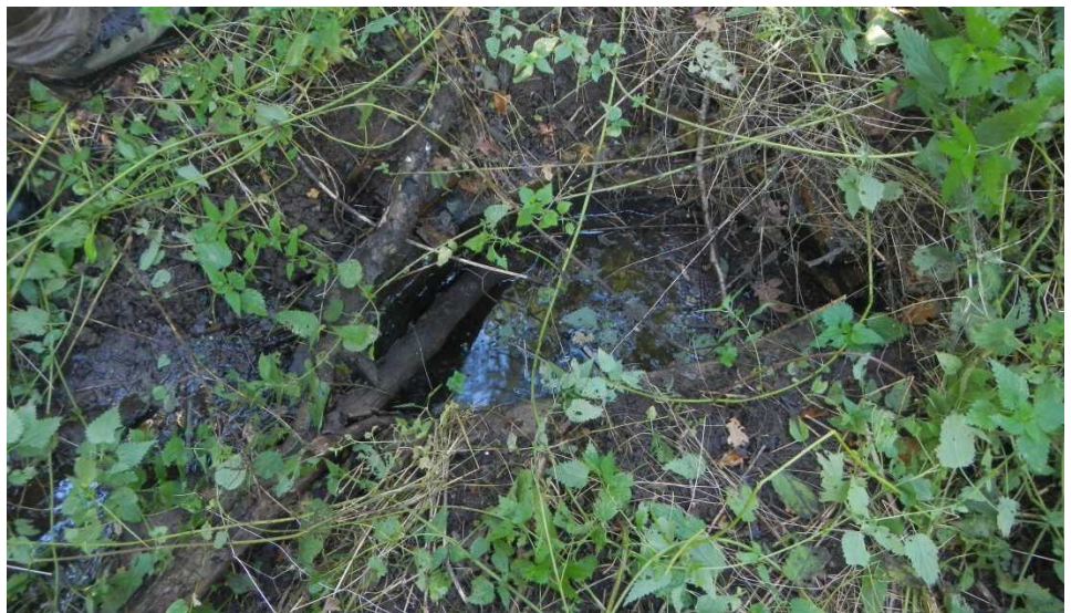
Figur 3: Indløb i brønden i starten af den rørlagte strækning. Vandet løber fra venstre mod højre i fotoet. Brønden er delvist dækket med en plade. 30-09-2015.
