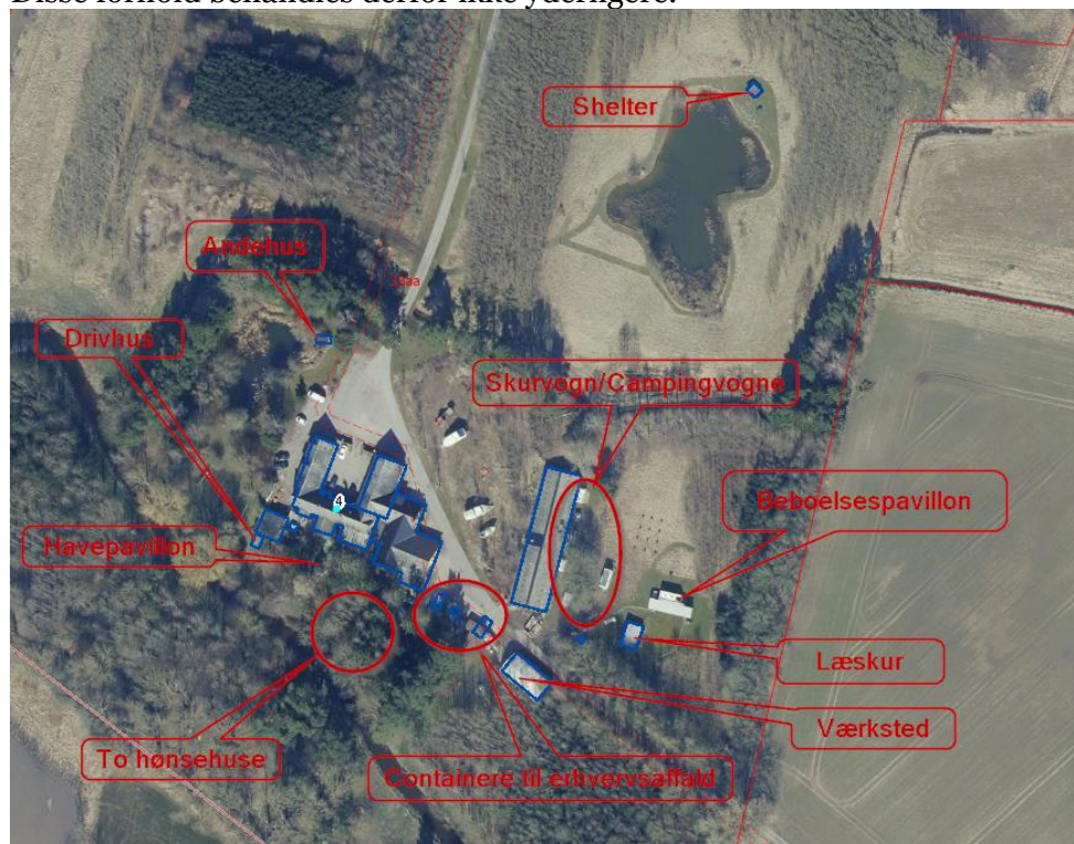
Figur 1 - Luftfoto af ejendommen med diverse ulovlige forhold markeret
