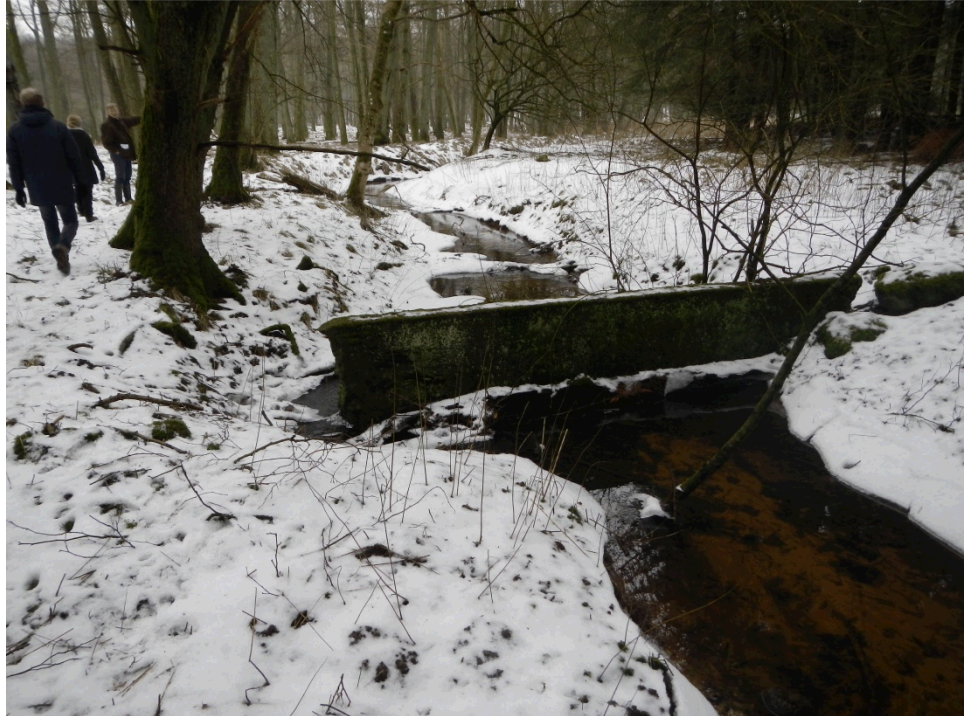
Figur 3-11 Foto af betonmur ca. 300 m nedstrøms sammenløbet af bagløbet og hovedløbet (foto 04-02-2014).
