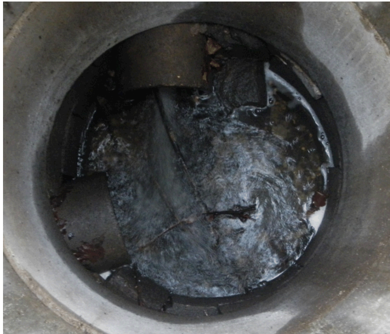
Figur 3-4: Brønd på nedstrøms side (øst) af Denderupvej. Bagløbet løber til i fotoets top og udløbet er i venstre side (foto 04-02-2014).
