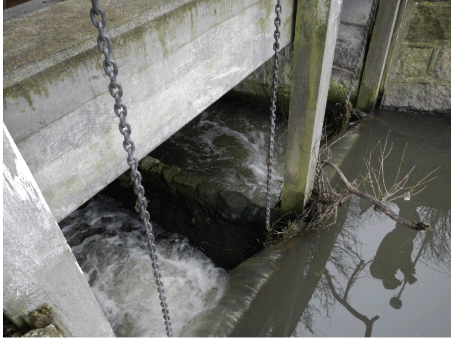
Figur 3-1 Afløb fra Møllesøen ved Blåbæk Mølle via et regulerbart stignbord med et styrt på ca. 0,5 m (foto 04-02-2014)
