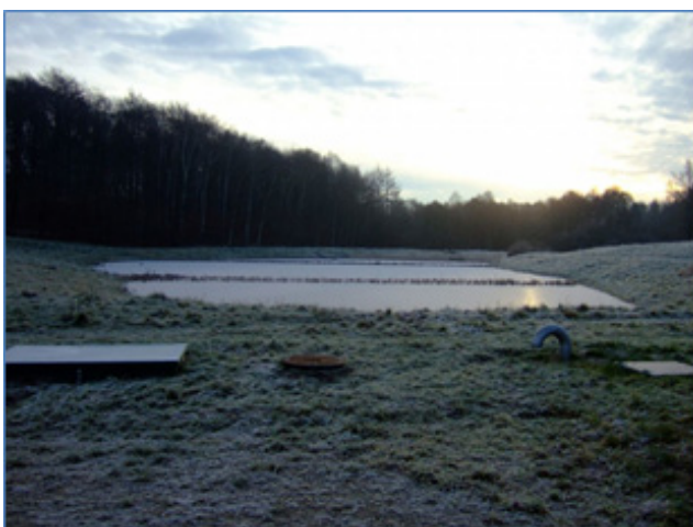
Figur 1 Et vådt regnvandsbassin i Silkeborg der er opdelt i tre sektioner
