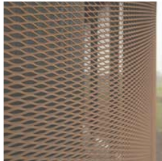
INDDÆKNING AF VENTILATIONSANLÆG
