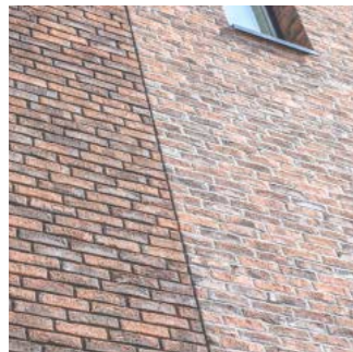
FACADER BEKLÆDT MED BLØDSTRØGNE RØDE TEGL MED FARVESPIJL
