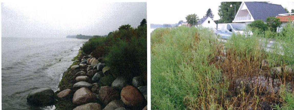
Figur 2.11 Situation langs Strandvejen i 2008. Strand er forsvundet, og der er høj strandvegetation på stenkastningen. Af Kjeld Larsen.
