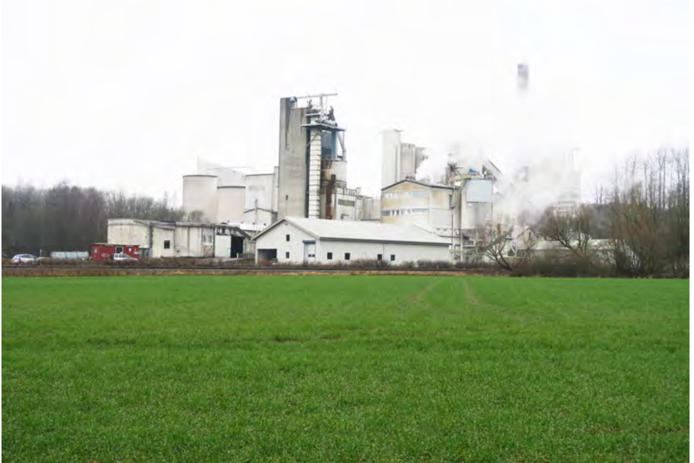
Det enorme, stadigt aktive, kalkbrændningsanlæg
