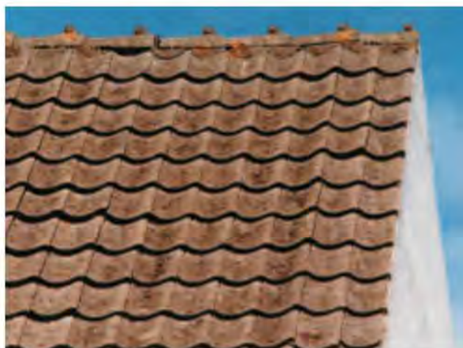
Opskalkningen er fint markeret med strømskifter i murværket på det øverste foto. Herover: Den gamle købmandsejendom på Hovedgaden 47 har en velbevaret tagbeklædning af cement-vingetagsten, formetlig fra bygningens opførelsesår - 1912! Bemærk de fine rygsten.
