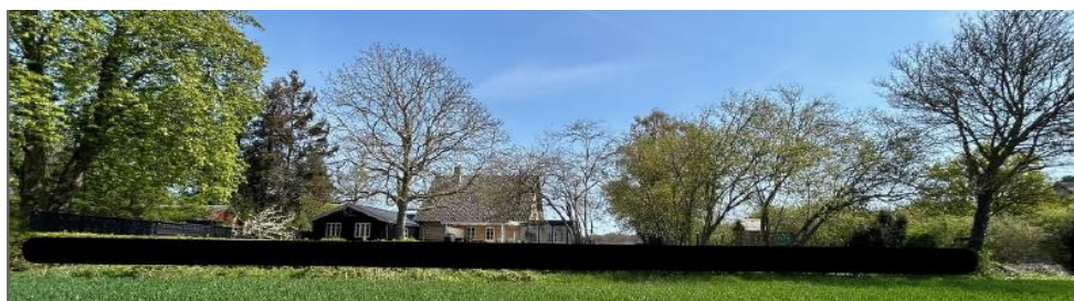
Figur 1: Solcellerne monteret på hegnet set fra vest.
