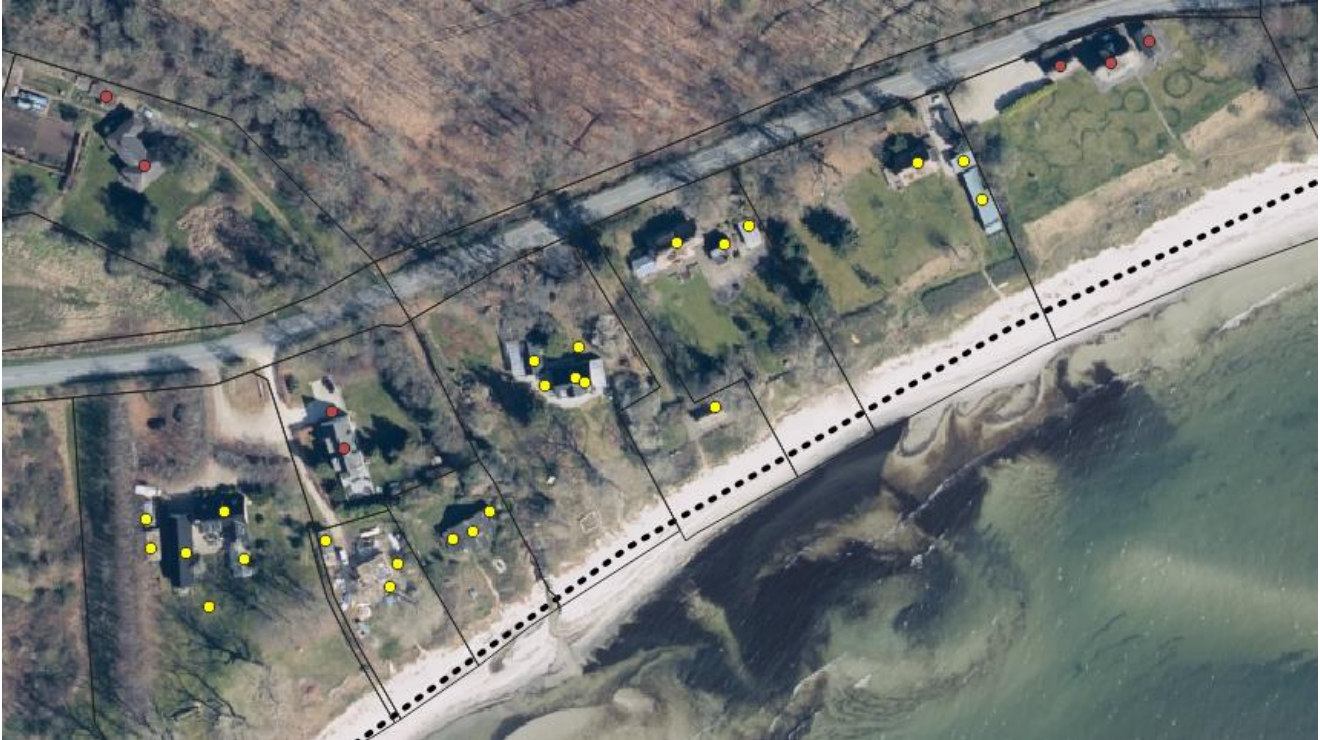
Figur 5.2: Oversigt over boliger og bygninger langs den nordlige projektstrækning (stiplet linje), som NIRAS vurderer udsat ift. erosion. Matriklerne der er upeget i nærværende analyse er markeret med gule prikker, men matriklerne der ikke er udpeget er markeret med røde prikker. Bygningsinformation indhentet fra BBR d. 16-12-2024.
