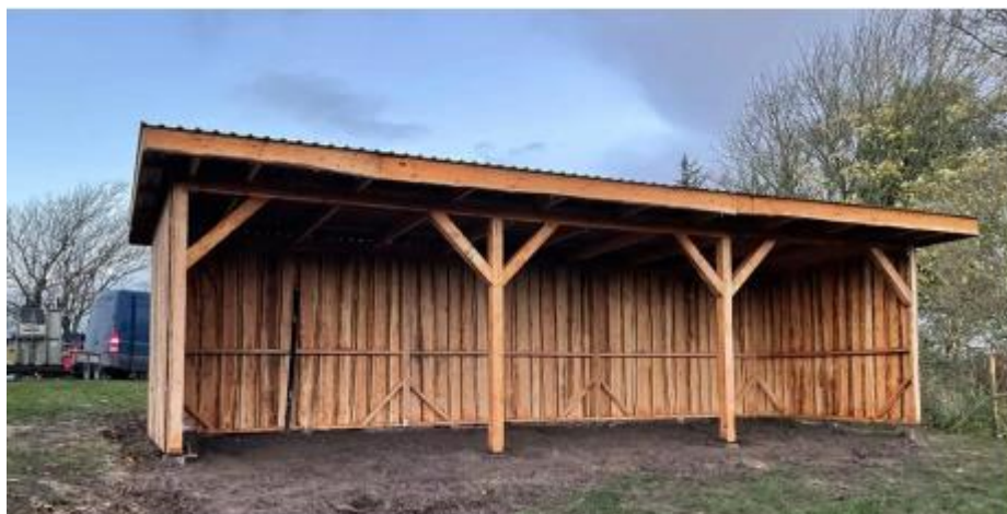
Figur 2: Læskuret opføres som vist på figuren
