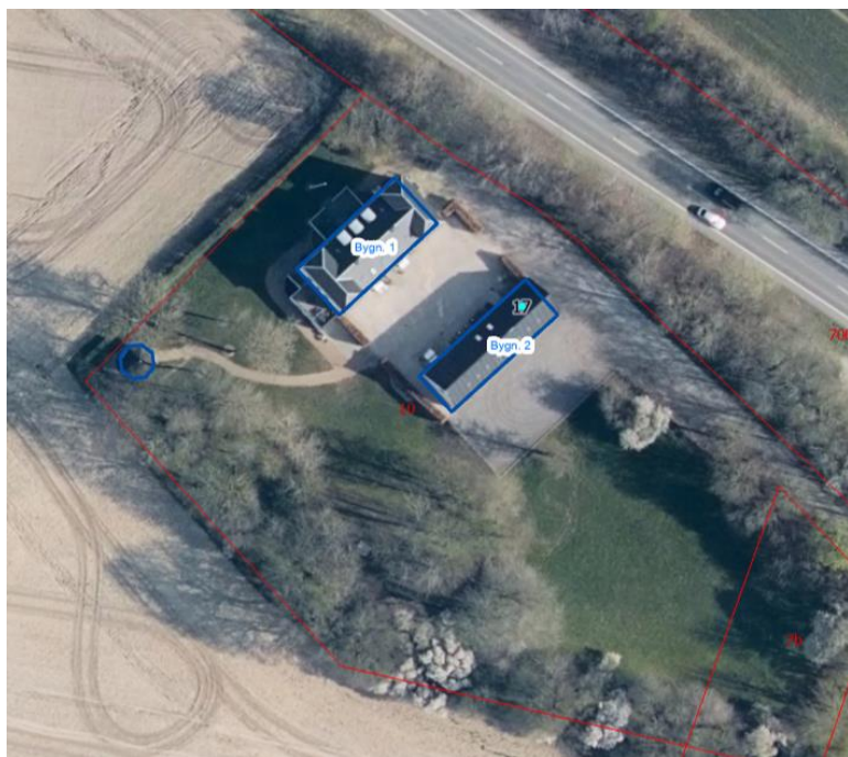
Figur 1: Luftfoto af ejendommen med bygningsnummer. Indretning af bostedet sker i bygning 1 og 2. Mellem bygning 1 og 2, samt sydvest for bygning 2 ses parkeringsforholdene. Havepavillonen er placeret i det vestlige hjørne af havearealet, markeret med blå cirkel.
