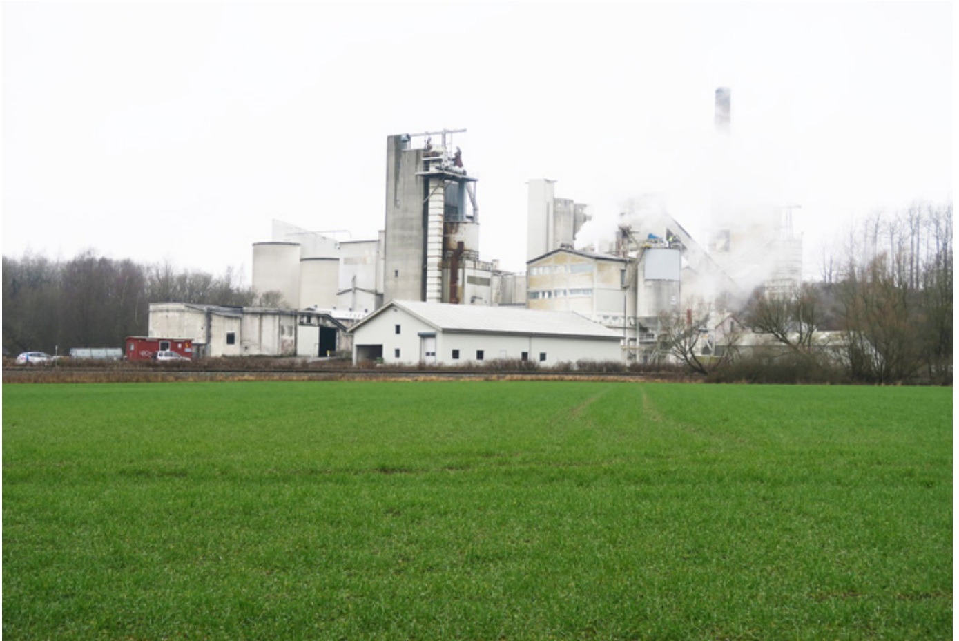
Det enorme, stadigt aktive, kalkbrændningsanlæg
