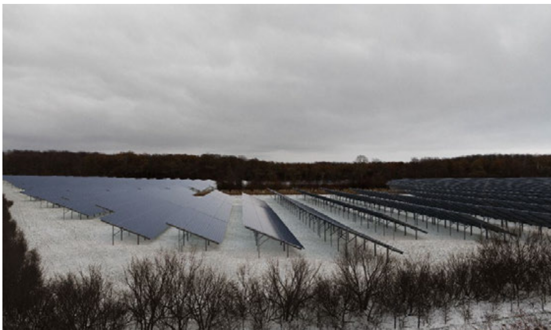
Figur 5-72: Visualiseringspunkt 12 – Visualisering af anlægget med opvokset nyt beplantningsbælte i en højde på minimum 4 meter.
