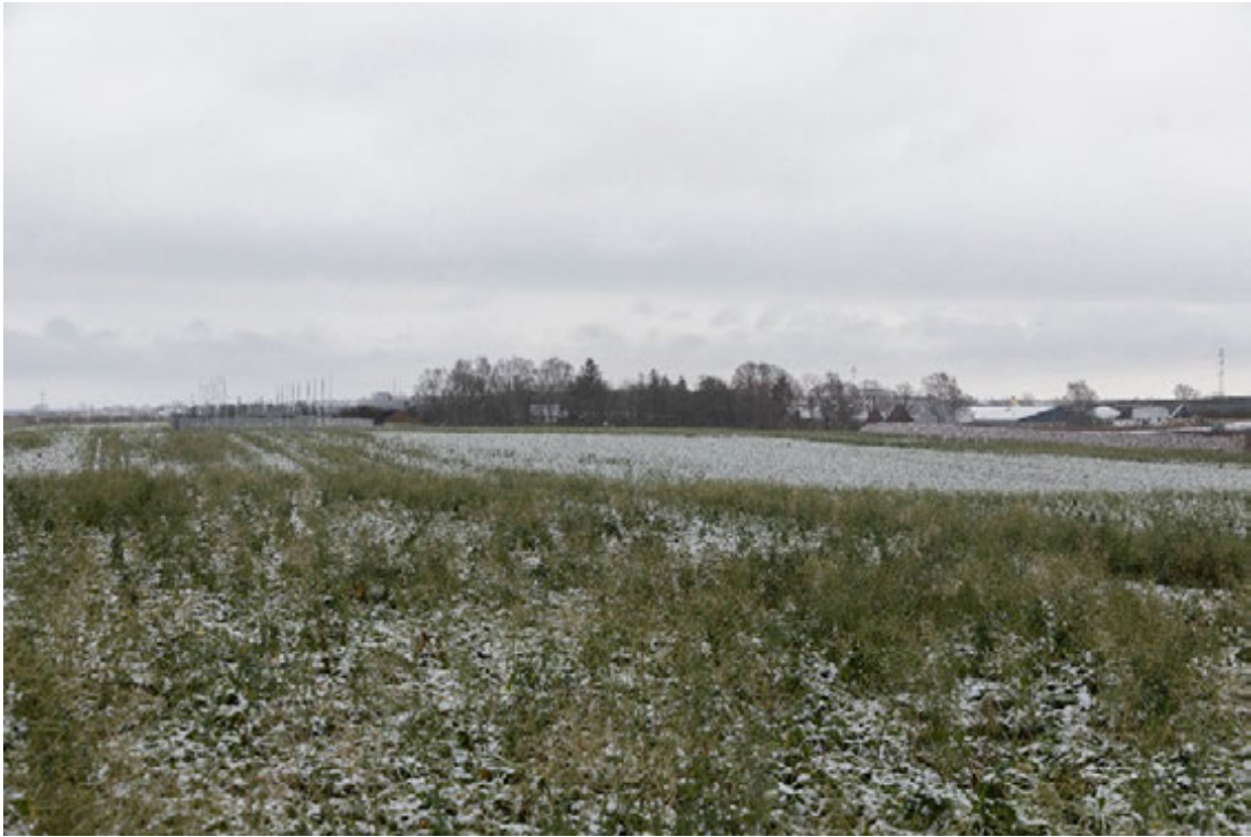
Figur 5-90 Visualiseringspunkt 8 – Visualisering af step-up transformeren med beplantningsbælter sammen med Energinets højspændingsstation nord herfor.
