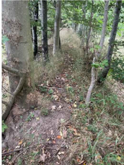
Figur 8-20 Diget er højt med tydelig vildveksel ovenpå. Fotoet er taget fra syd mod nord.
