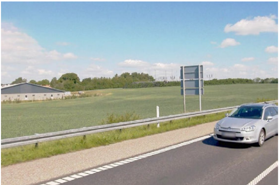
Figur 5-92: Visualiseringspunkt 10 – Visualisering af step-up transformeren med beplantningsbælter sammen med Energinets højspændingsstation nord herfor.
