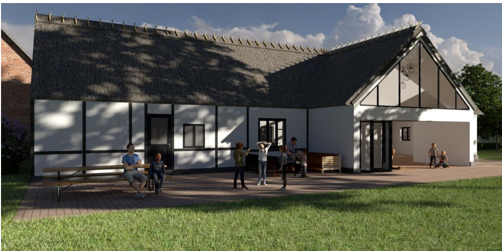
Figur 1: Facaden efter ombygning. Udvendig vil det kunne ses at der er monteret gavlvindue og skydedør.
