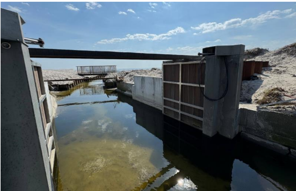
Figur 4-8 Ny-etableret sidehængt sluse (hollænder-sluse) på Solrød Bæk
