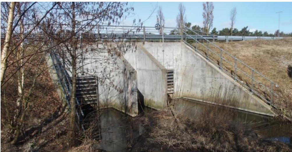
Figur 4-6 Stigbordssluse - Karlstrup Møllebæk, Solrød Kommune.
