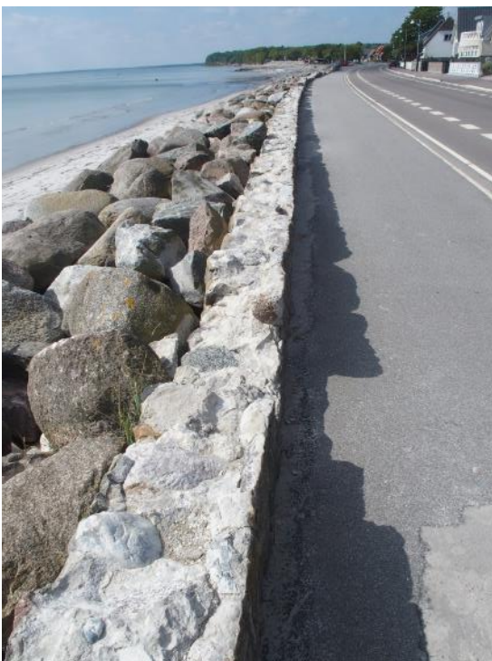
Figur 4-3 Overside af kampestensmur samt dele af kampesten blev slået af muren ifm. stormfloden 2023.
