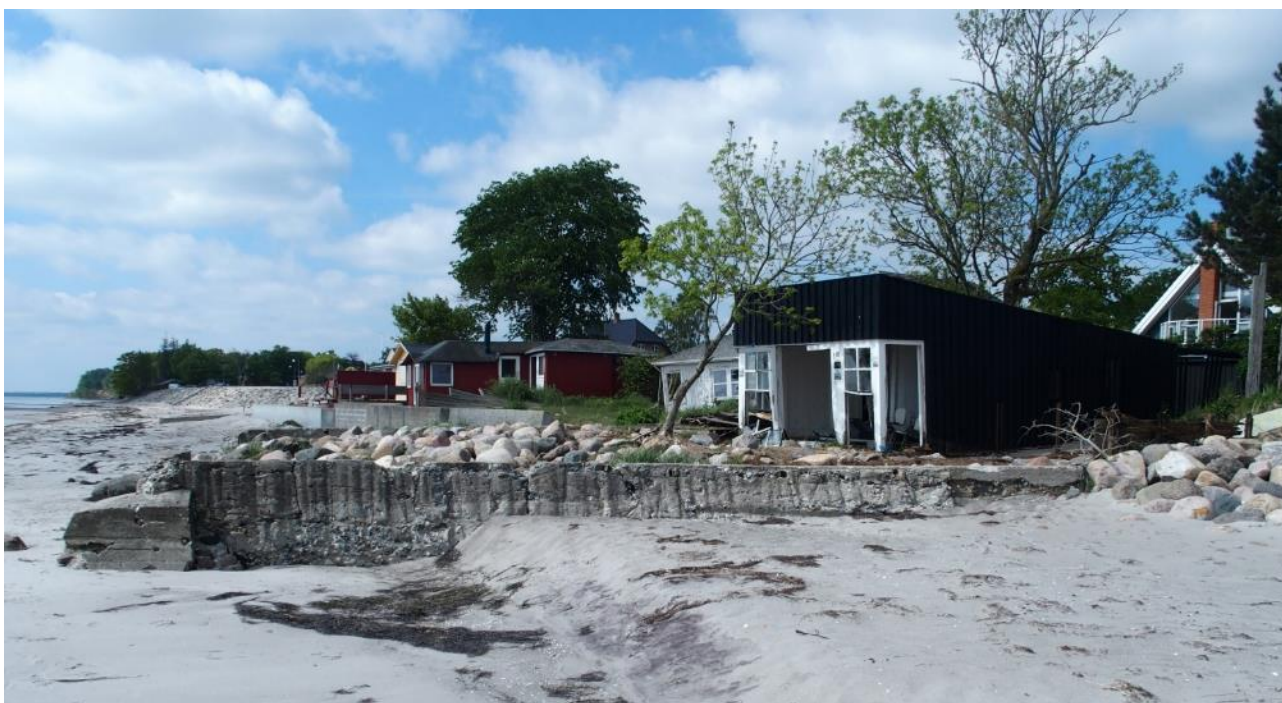
Figur 4-11 Nuværende stormflodsmur langs Strandhuse 4 (sort bygning). De oplagte kampesten bør genanvendes til at beskytte en kommende stormflodsmurs nedre yderside, svarende til stormflodsmur-strækningerne nord for åen.
