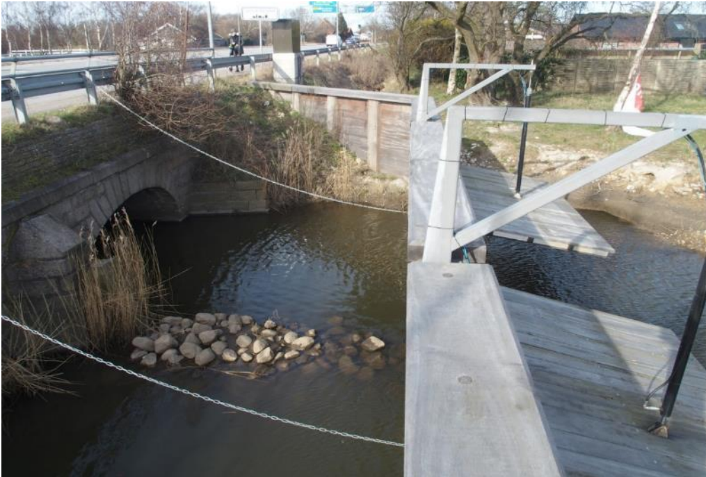
Figur 4-7 Tophængt klap-sluse, Skensved Å, Køge og Solrød Kommune (er placeret på kommunegrænsen).
