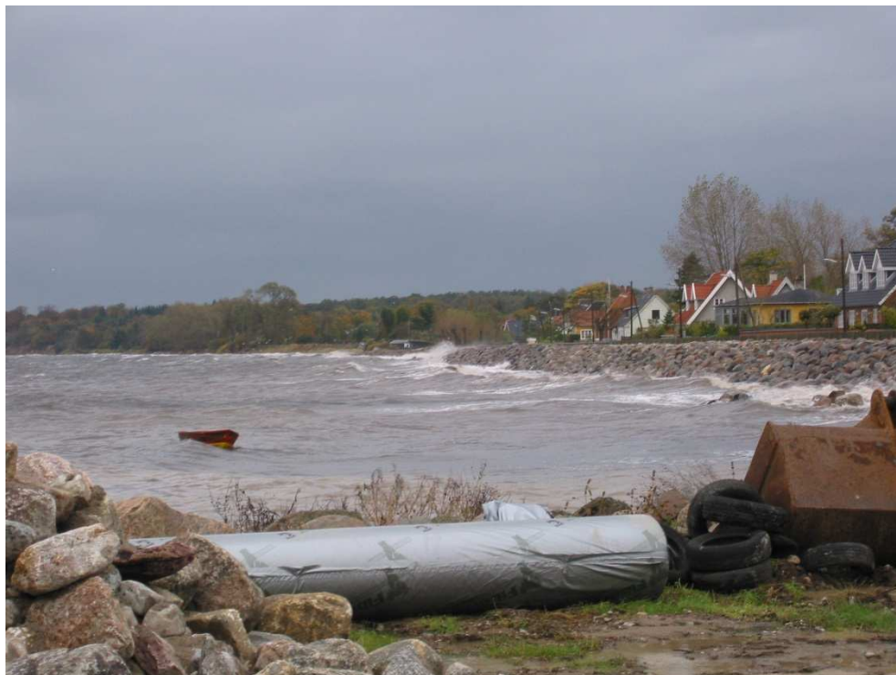
Figur 2.17 Den i 2003 netop etablerede stenkastning på den nordligste del af kysten syd for Faxe Ladeplads Havn i stormvejr.
