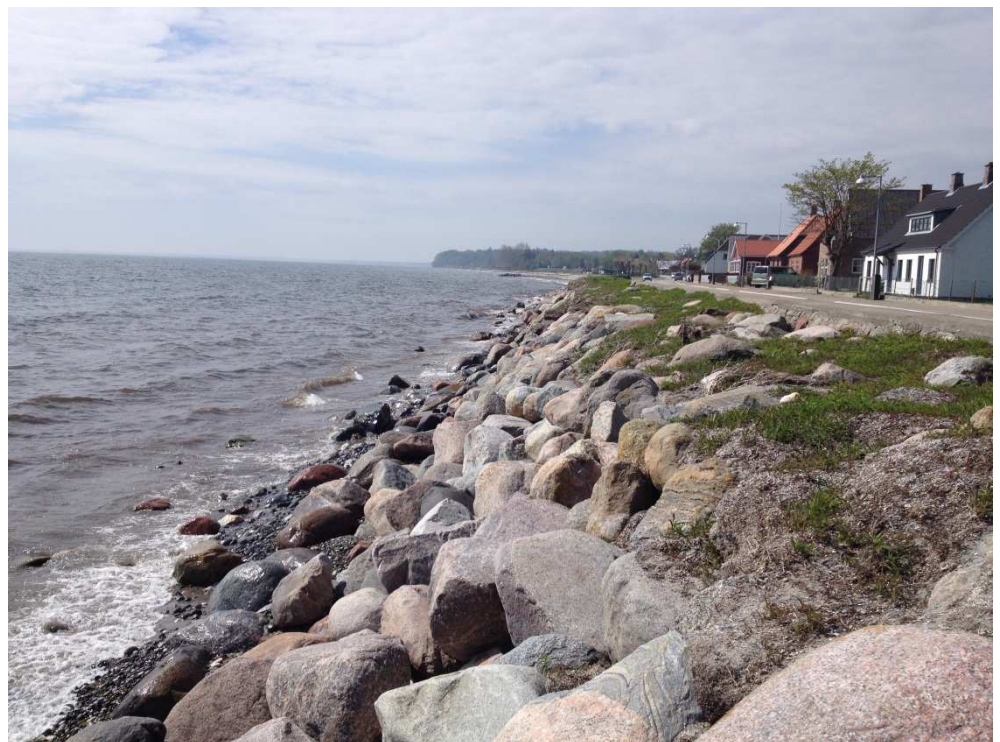
Figur A.9 Tang og bevoksning på stenkastningens krone starter ved ud for hus nr. 26 på Strandvejen og fortsætter sydpå.
