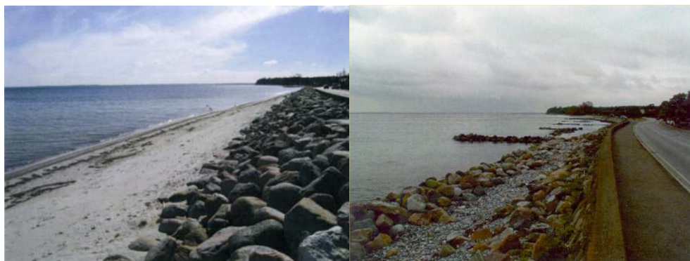
Figur 2.21 Til venstre: Kysten i 2005 efter etableringen af stenkastningen. Til højre: Kysten i 2001 før etablering af stenkastningen.
