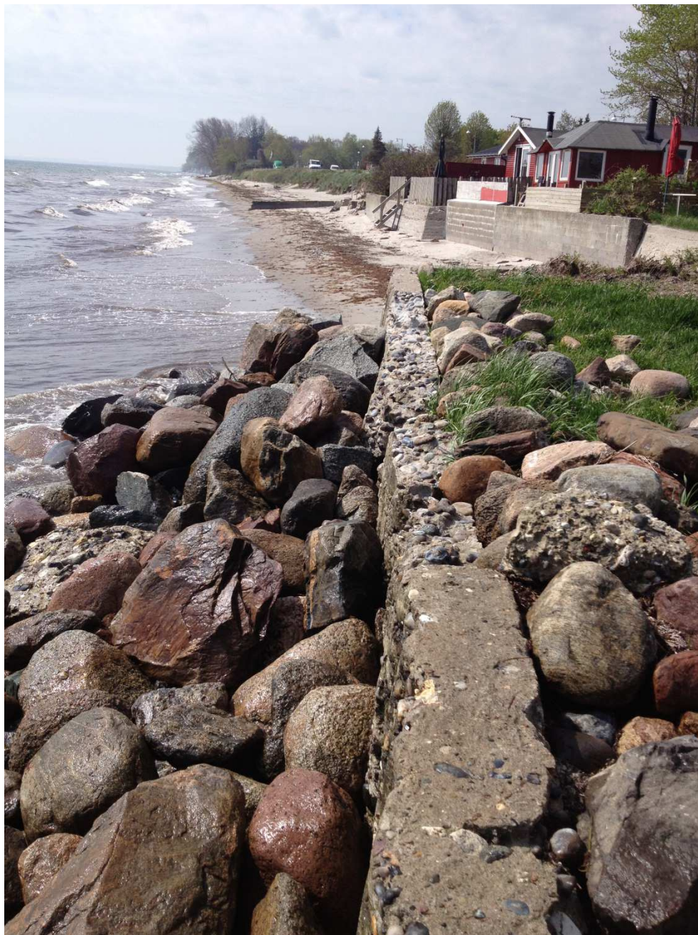
Figur A.17 Opfyldning af strandgrund med støttemur og stenkastning.
