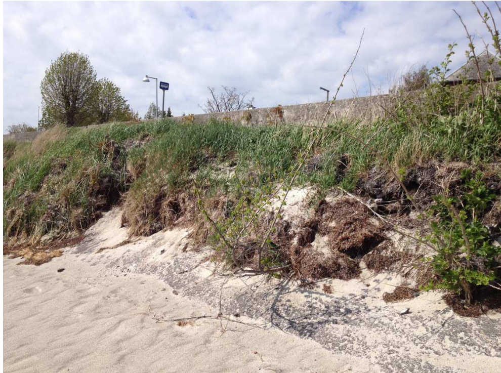
Figur A.20 Asfalskråning med jord og bevoksning ovenpå.
