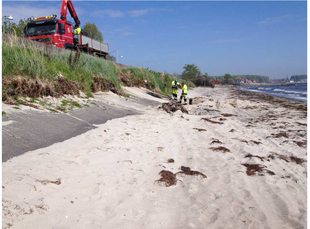
Figur A.22 Sandstrand samt reparation af asfalkr ning, set mod nord.
