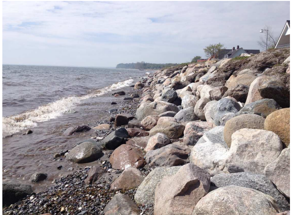
Figur A.8 Enkelte dæksten faldet ned fra stenkastningen ud for hus nr. 30 og ca. 50 m sydpå.
