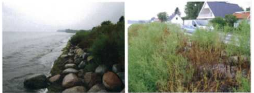
Figur 2.20 Kysten langs Strandvejen i 2008. Sandstranden er eroderet bort og der er høj strandvegetation på stenkastningen. Billede taget af Kjeld Larsen, Faxe By- og Kystlaug, fra DHI's rapport fra 2010 vedr. udvidelse af havnen Ref. /2/.
