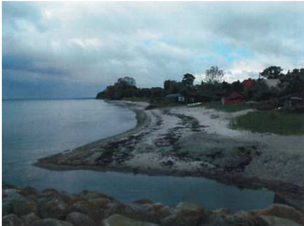
Figur 2.12 Faxø Å's udløb i 2001. Der ses lidt lokal læsideerosion på grund af ledeværket.
