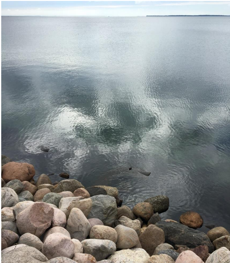
Figur 4-10: Vandudskiftningsrør under vandoverfladen. Mod sydøst
