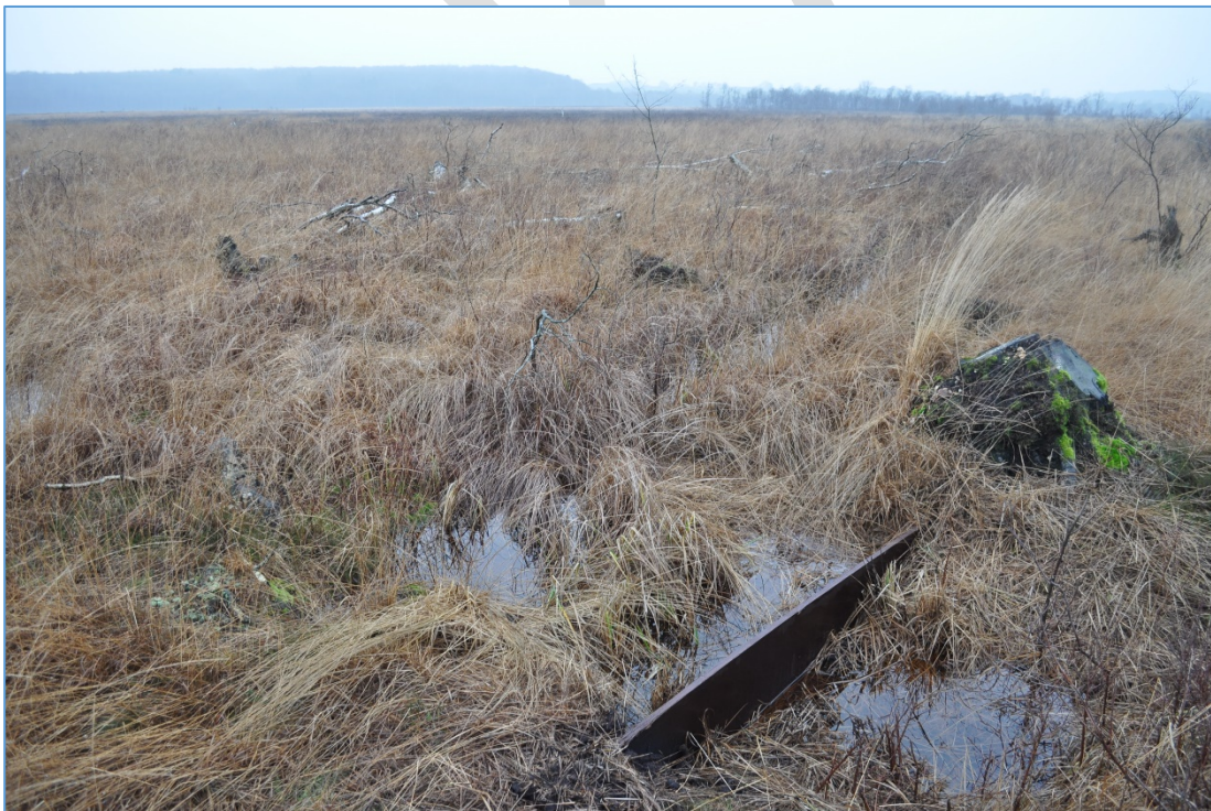
Figur 2. Simpelt pladespuns, som sættes i, hvor der findes nye utætheder. Her tørveskær T62.
